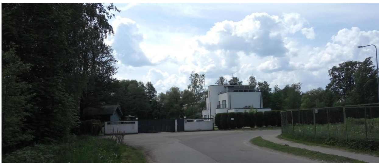
11.attēls. Savrupmāja "Atpūtas ielā 6" (skats no caurbrauktuves lokālpilnojumā vidusdaļā)
